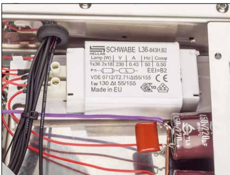
Das sind Drosseln für Leuchtstofflampen, die hier in der Stromversorgung zweckentfremdet werden
